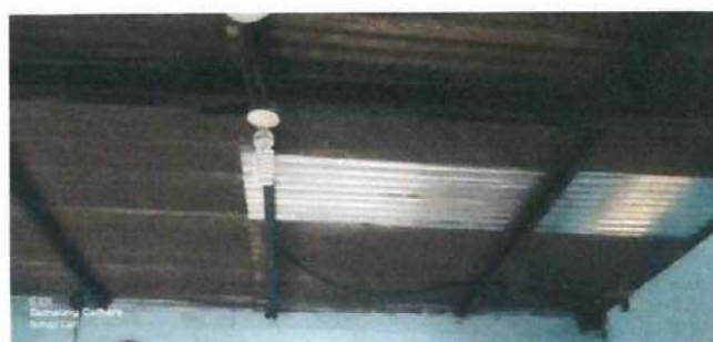
Foto 4: Se observa el deterioro de las laminas y de las costaneras del aula de Segundo básico.
