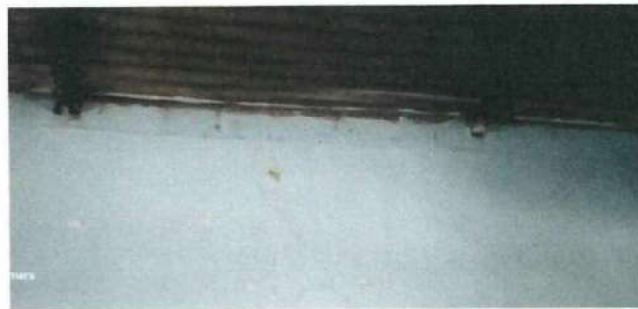
Foto 6: Se observa la filtración de agua por el deterioro de las láminas del aula de Tercero básico.
