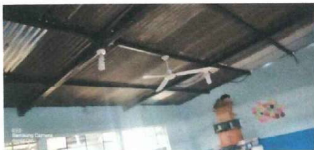
Foto 3: Se observa el deterioro de las laminas y de las costaneras del aula de Primero básico.
